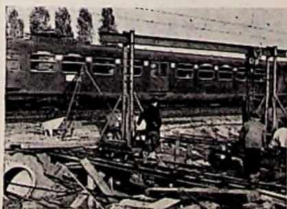
Ongestoord gaat het werk voort, terwijl de treinen voorbij denderen
